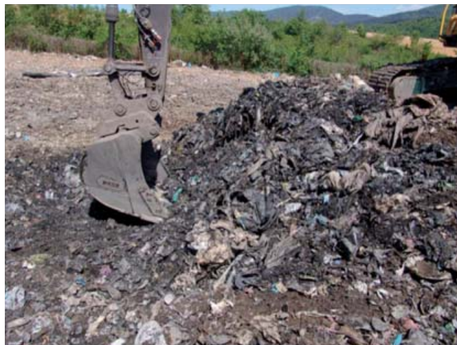
Obrázok 2: Landfill mining – odťaženie 15 rokov starej skládky. (foto MH)
