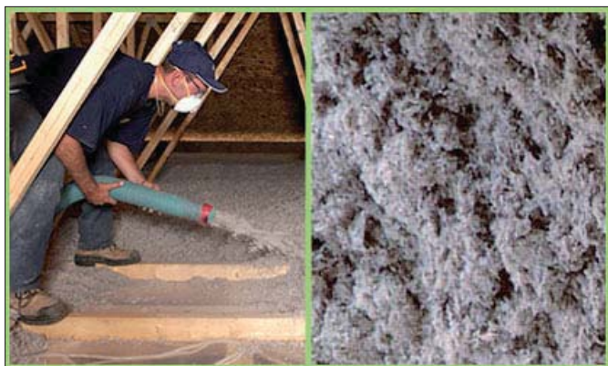
Obr. 3: Izolácia z celulózy podľa patentu US7758719B2
